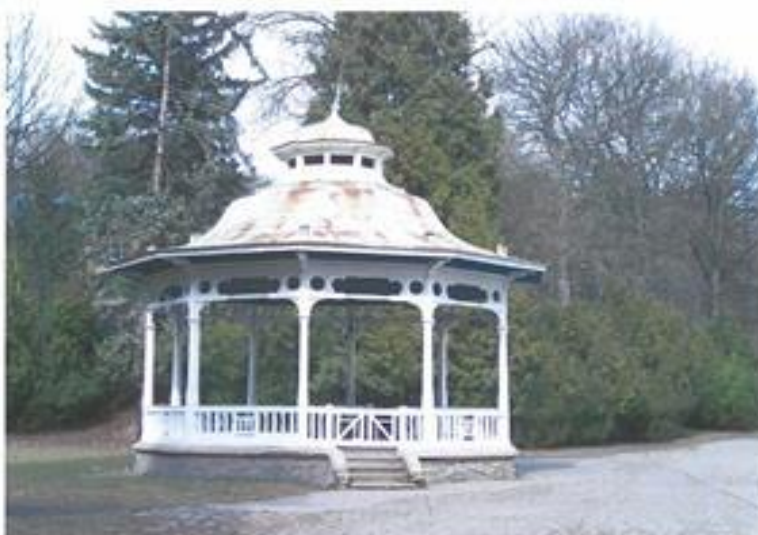
STAV PAMÁTKY PŘED OPRAVOU:
